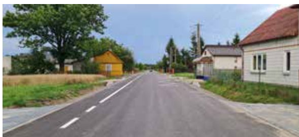
Przebudowana ul. Słowackiego
